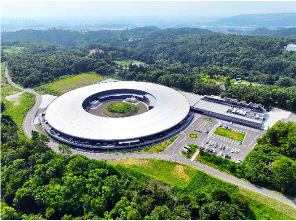
Fig.1 NanoTerasu 全景写真 (2024年8月)
