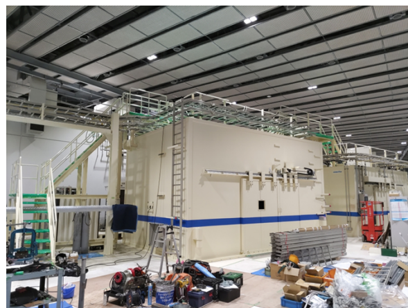
図 5 BL39XU に建設中の XES 計測専用の実験ハッチ。現在の実験ハッチ 1 と実験ハッチ 2 の間に建設され、図 4 で示されている XES 計測装置が移設される。
