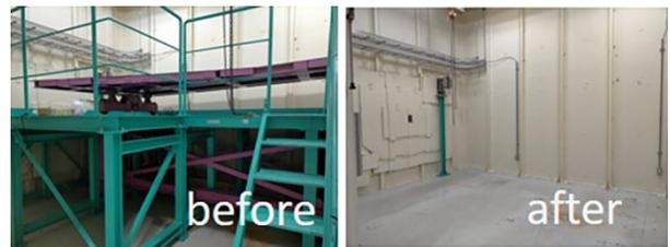
図 1 傾斜架台撤去前後の EH2 の様子。
