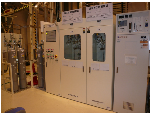
図8 反応性ガス供給排気装置。
