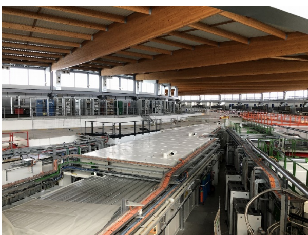
図 2 SOLEIL の施設内外の写真。上はエントランス部、下は実験ホール内の 2 階からの写真である。天井には 7.7 t のクレーンが配置されている。
