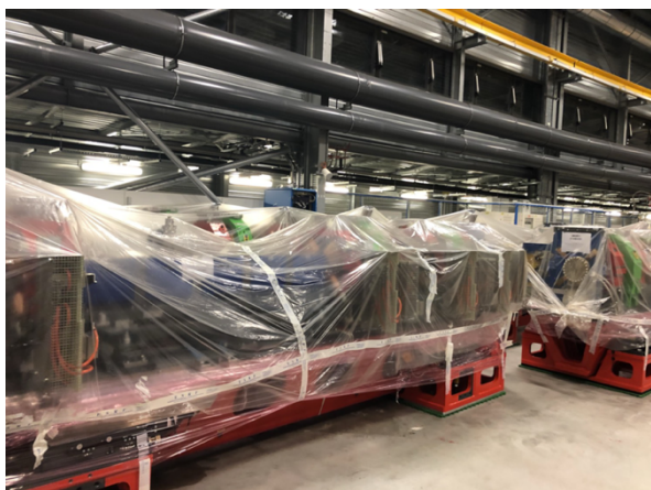
図4 増築された実験ホールに置かれている EBS リングに用いる電磁石
