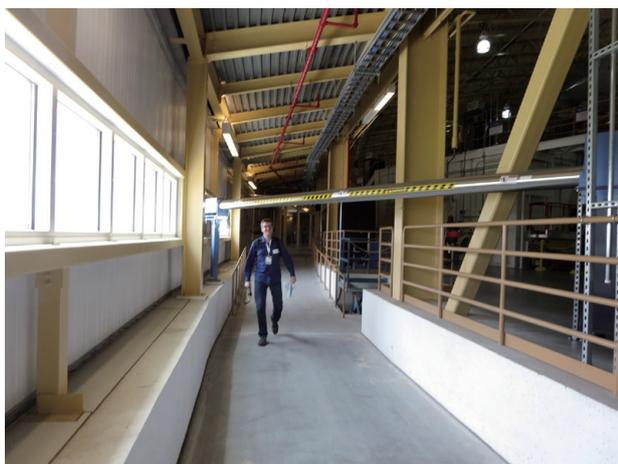
写真9-4 Nanoprobe 実験ステーション建屋（左手）に向かう延伸ダクト。下はスロープになっておりかなり背丈のある人でも容易に潜れる。
