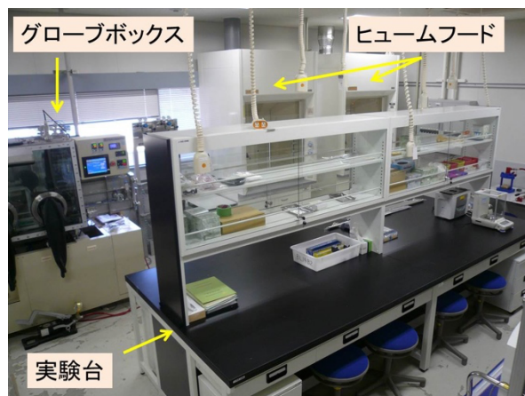
図9 BL14B2 測定準備室内に設置されたグローブボックス、ヒュームフードおよび実験台。
