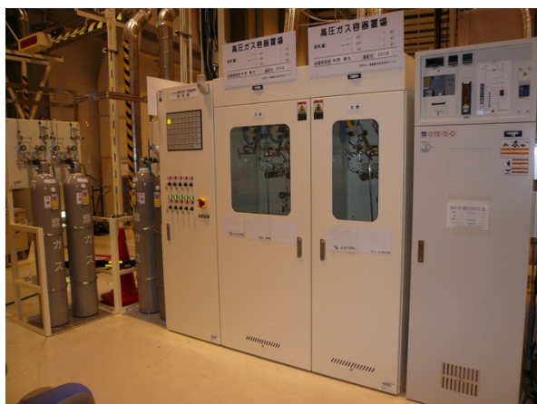
図8 反応性ガス供給排気装置。
