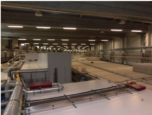
図4 PETRA-IIIの実験ホールの内部。実験ハッチが隙間なく設置されているように見える。
