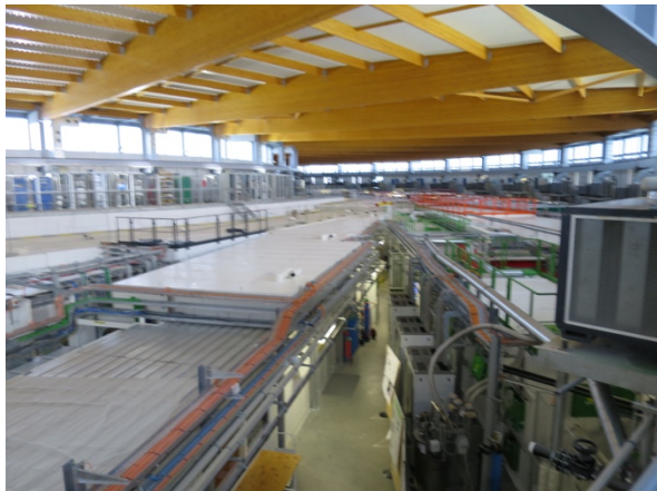
図 4 採光用の窓で明るい SOLEIL の実験ホール。遮蔽ハッチとキャビンが並んでいる。
