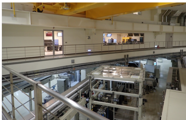
図 1 TPS の実験ホール。吹き抜けの 1 階がビームライン。2 階に見えるのが中央制御室。
