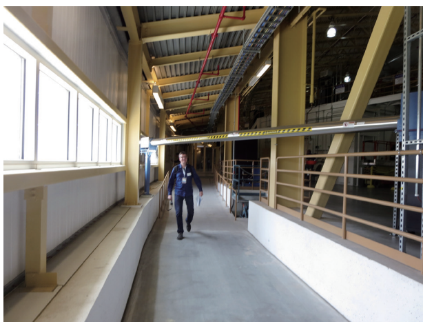
写真9-4 Nanoprobe 実験ステーション建屋（左手）に向かう延伸ダクト。下はスロープになっておりかなり背丈のある人でも容易に潜れる。
