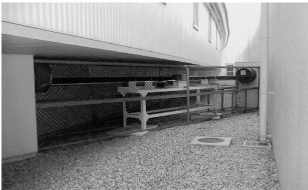
図5 蓄積リング建屋とRI棟建屋をつなぐビームパイプ。内部に衝撃波遅延のためのディスクが設置されている。
