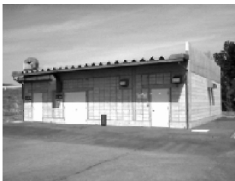
少量危険物貯蔵庫外観
