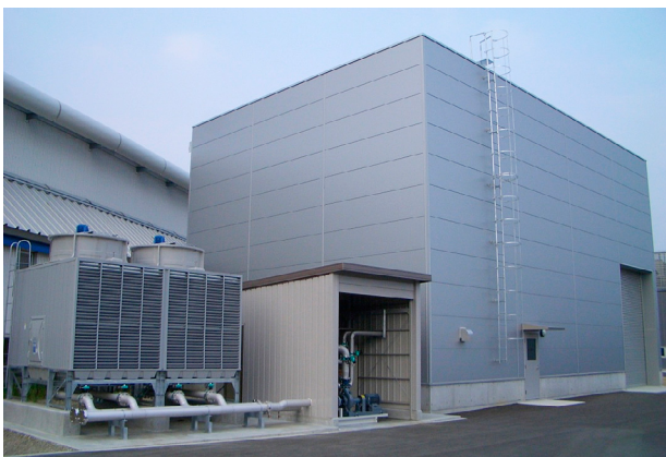
(写真2) LEPS2実験棟の外観。右側が実験棟、左側が冷却水システム、奥がリング棟となっており、レーザー電子光は左側から輸送される。
