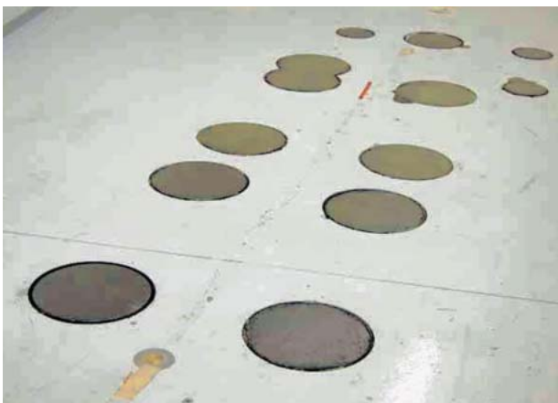
写真2-c コンクリート充填
