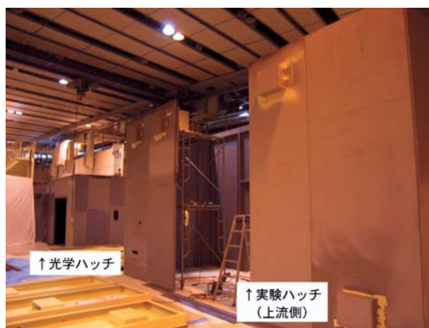
図1 遮蔽ハッチ建設状況
