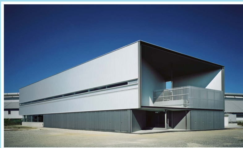
豊田ビームライン実験棟全景
