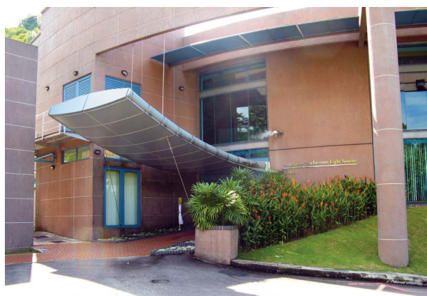
図4 Singapore Synchrotron Light Source施設入口
