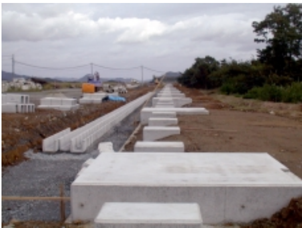
図5 BL29XU長尺ビームライン基礎工事風景。光源から200m付近地点からの下流側(左)および上流側(右)。 Current view of 1km beamline construction; left: downer stream, right: upper stream from 200 m point from the source.
