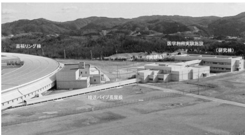
写真1 中尺ビームライン屋外部全景
