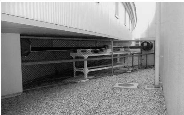
図5 蓄積リング建屋とRI棟建屋をつなぐビームパイプ。内部に衝撃波遅延のためのディスクが設置されている。
