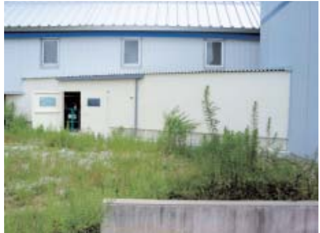
Fig. 3 屋外機器収納ハウス
