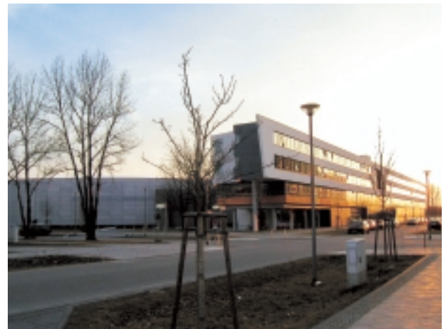
図13 BESSYの事務・研究棟と蓄積リング棟
