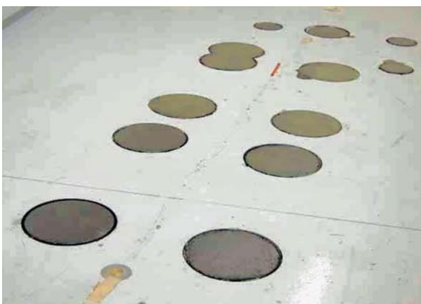
写真2-c コンクリート充填
