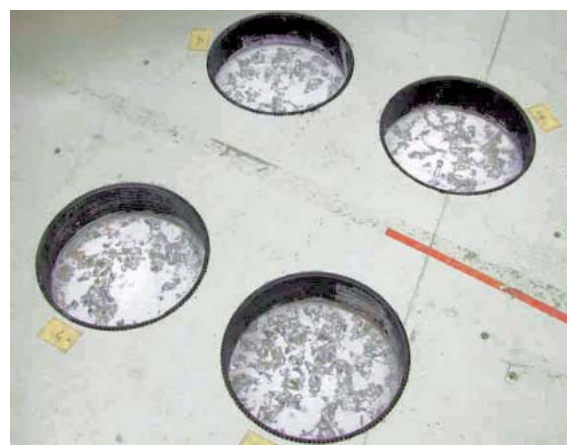
写真2-b 底面密着性向上とゴム取付
