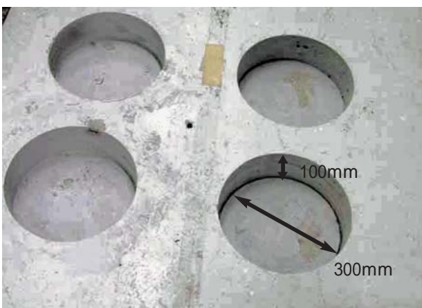
写真2-a 300mm x 100mmで床を抜く
