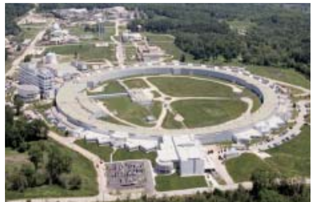
図1 APS放射光リングとCNM。手前の建物がCNMで、Electronic & Magnetic, Materials & Devices, Nanobio Interface, Nanofabrication Nanophotonics, Theory & Modeling, X-ray Microscopyの6つのグループが活動している。
