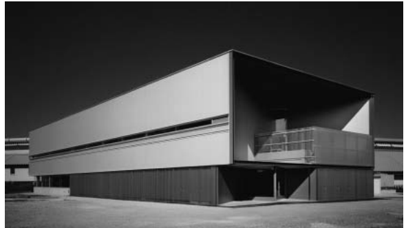
図5 豊田ビームライン実験棟の竣工写真
