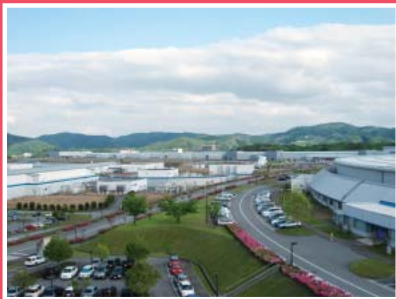
中央管理棟屋上から臨む蓄積リング棟・ シンクロトロン棟・線型加速器棟・XFEL施設(仮称)
