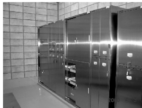
少量危険物貯蔵庫内部（保管室4）
