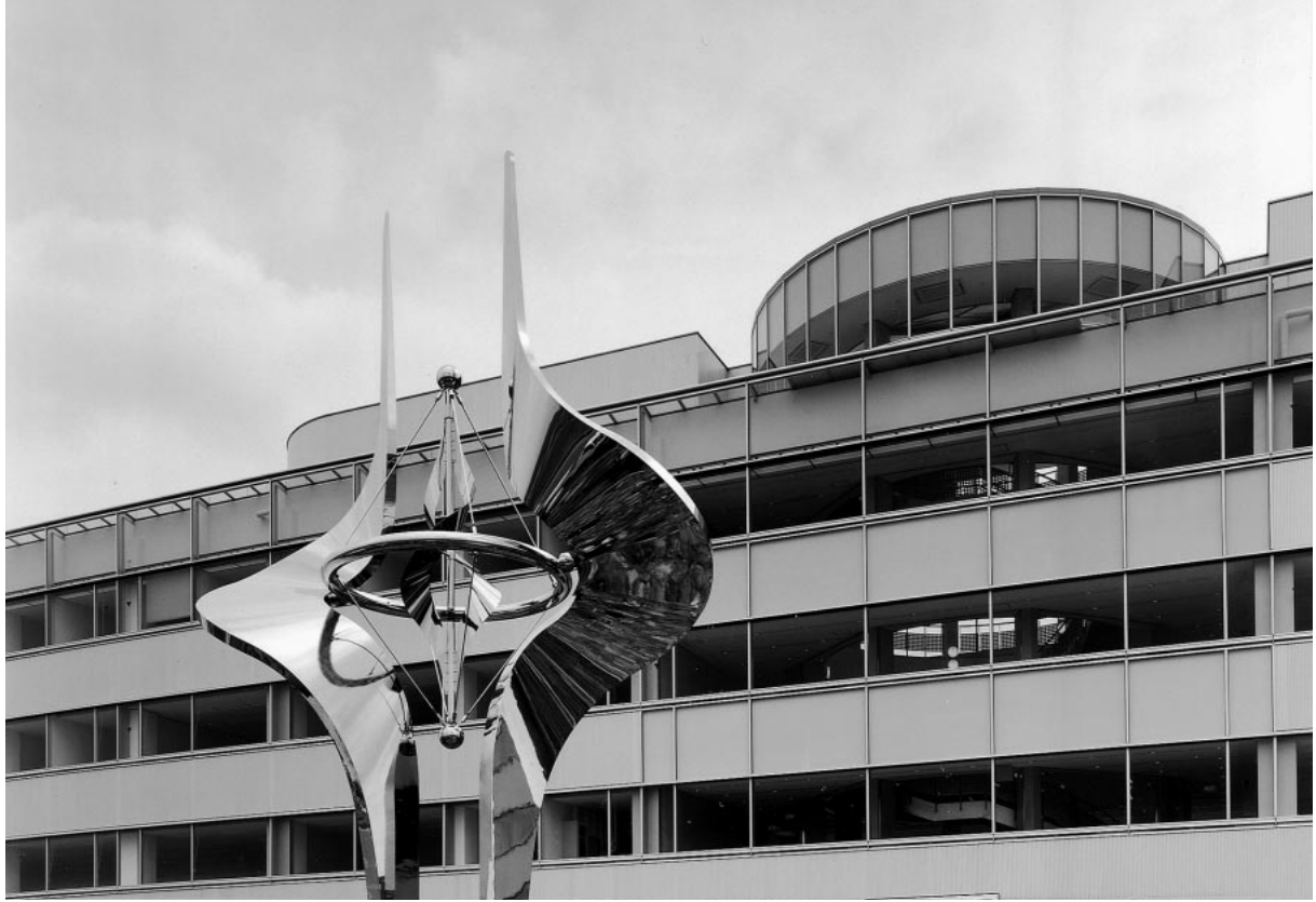
シンボルタワー
