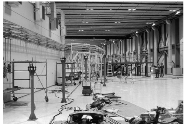
図7 BL25SUビームライン設置工事風景
