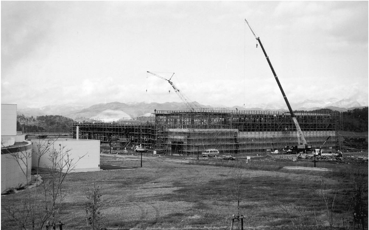
組立調整実験棟建設風景（平成9年2月）
