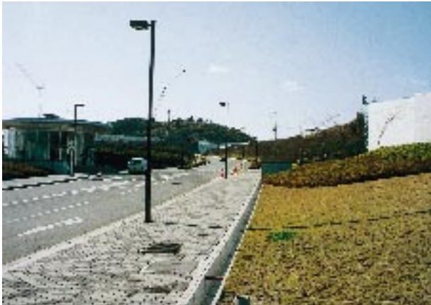
SPring-8正門付近 (H8.10) 左：正門、右：給水施設、奥は蓄積リング棟。
