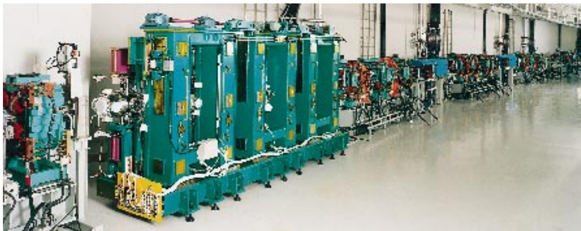
蓄積リング棟マシン収納部 (H8.8)
