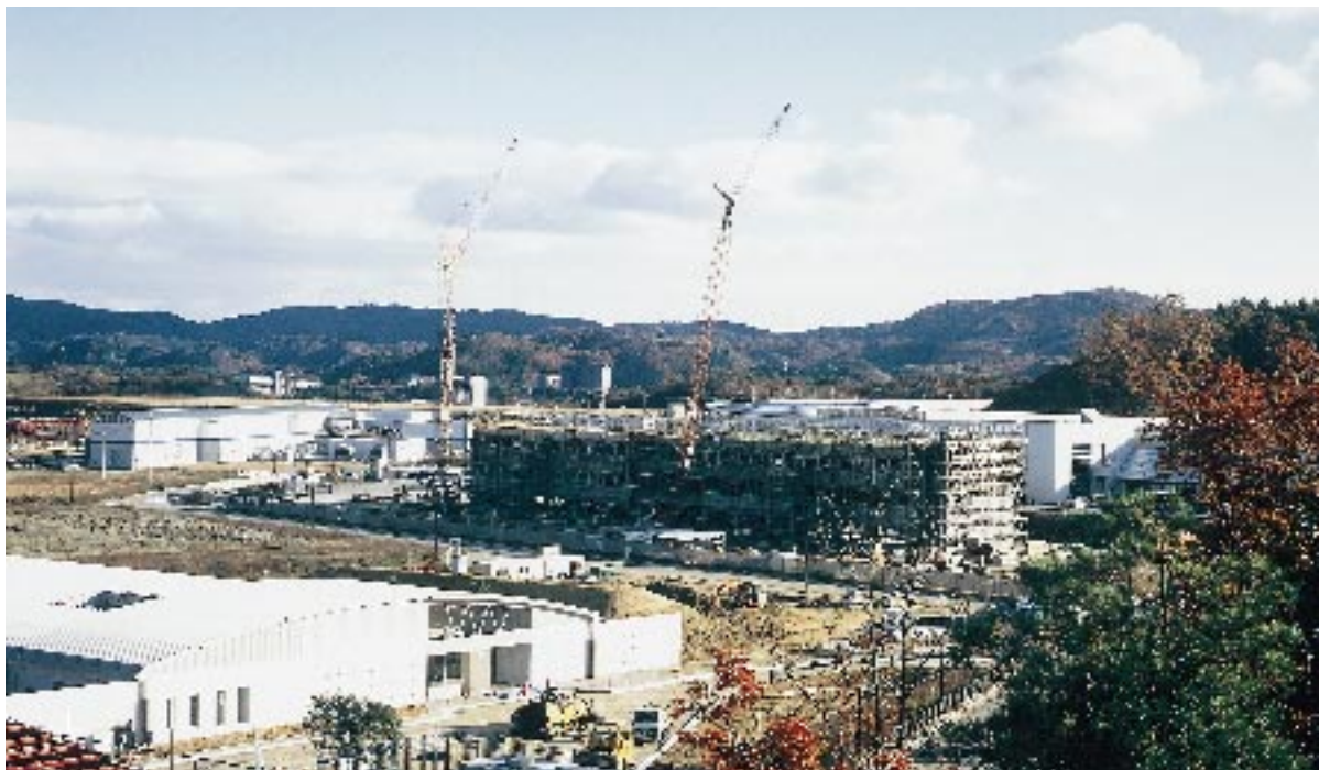
中央管理棟建設風景 (H8.12) 手前：食堂、中央：中央管理棟、左：線型加速器棟、右奥：蓄積リング棟
