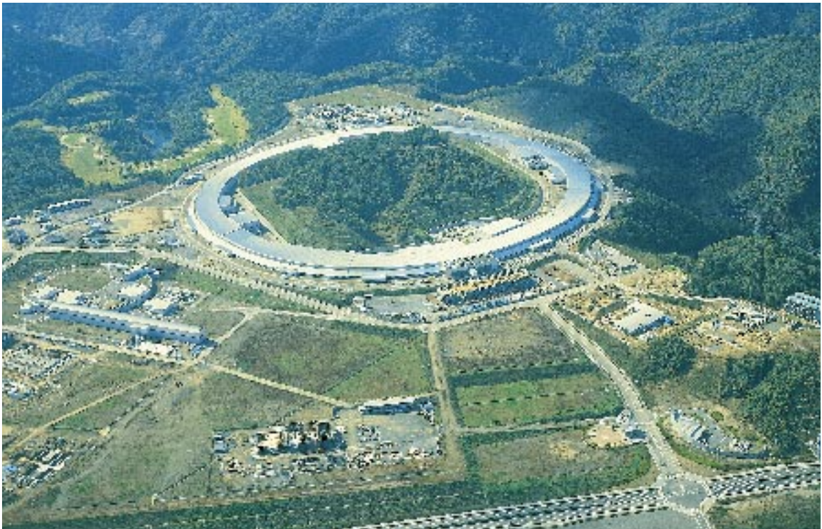
SPring-8の全景 左：線型加速器・シンクロトロン、中央：蓄積リング、右端：研究交流施設、右前：正門
