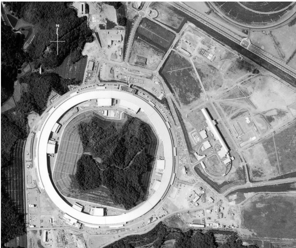
写真1 SPring-8敷地の航空写真(平成8年7月撮影)
