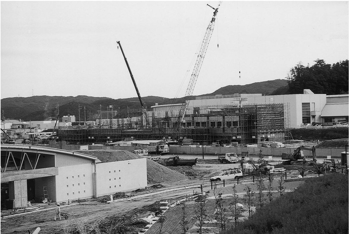
中央管理棟 建設風景 (H8,10月)
