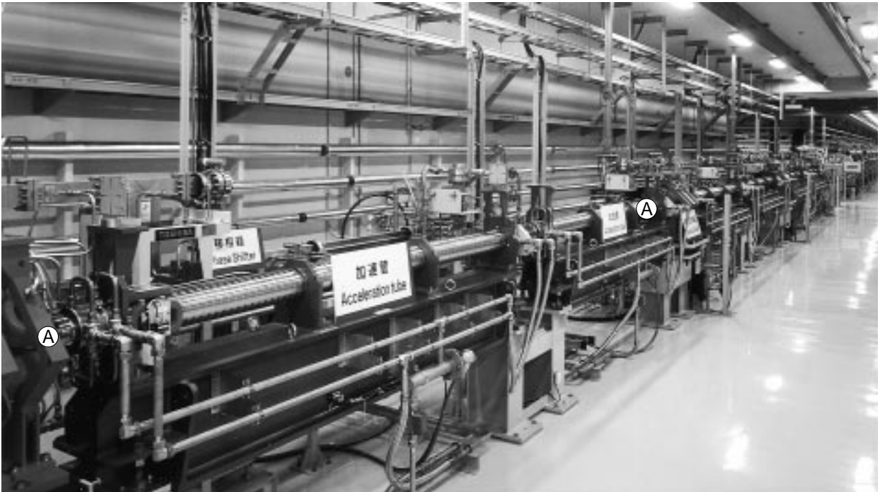
写真2 加速管室内部
